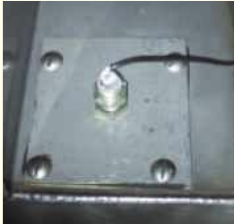
Wannebesichtigungsklappe und Sicherheit Wassermangel
